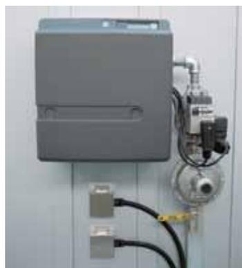
Компактная горелка для стандартных моделей до NB 600
